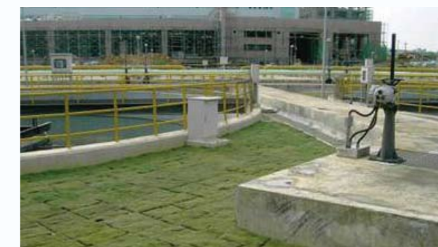
圖二：台中園區污水處理廠廠區 (二沉池) 視覺景觀綠美化成果。
