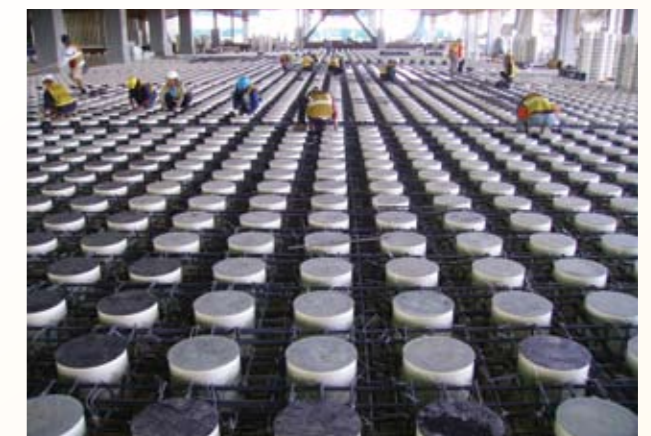
95/12/05 格子樑鋼筋綁紮
