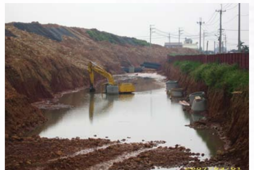
臨時污水管搶作施工照片
