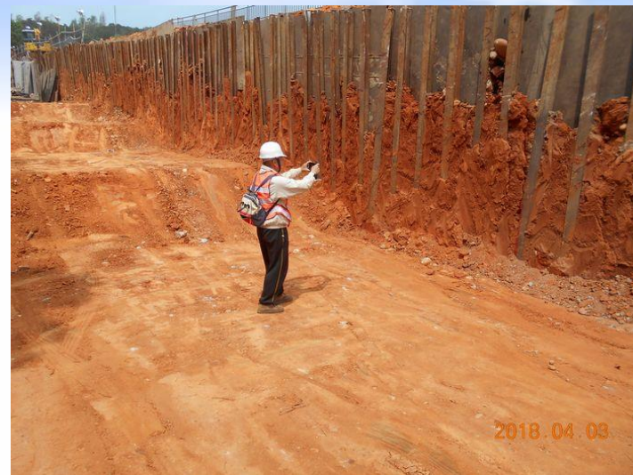
西區配合工程及景觀工程(107.4.3)
