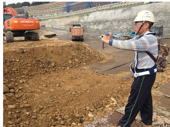
台積電中科十五廠7期興建工程(107.4.12)
