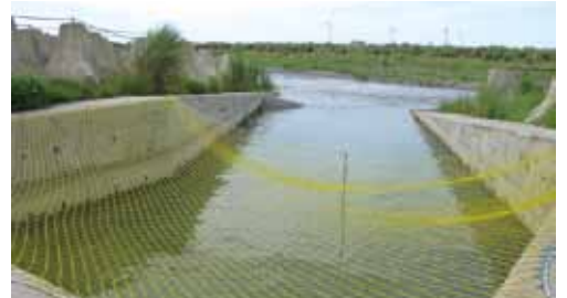
放流管出水口水利設施銜接匯入大安溪。
