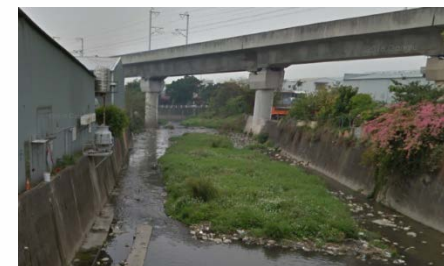
筏子溪上游生活污水排放現況
