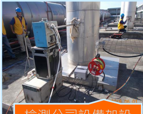
檢測公司設備架設 及採樣
