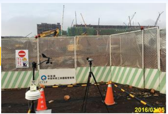
工區周界1(中科路)
