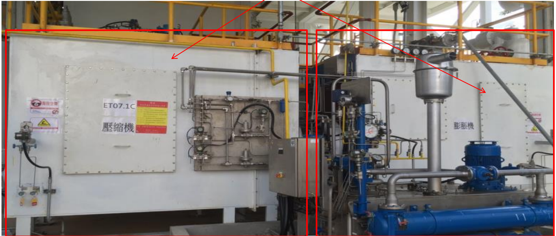
透平機內部填塞及外殼包覆
