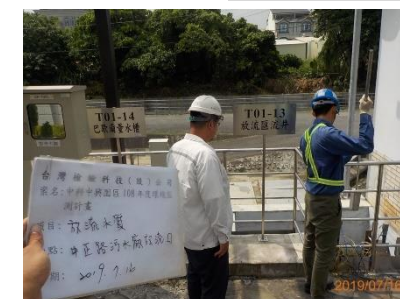
中正路污水廠
