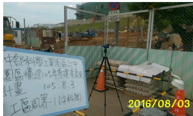
工區周界1(中科路)
