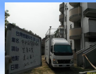
虎山國小環境現況
