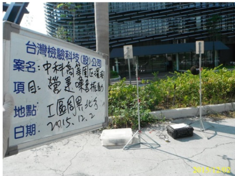
工區周界北方
