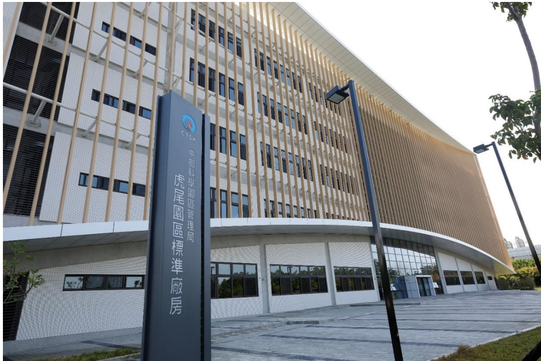
▲ 中科虎尾園區標準廠房
