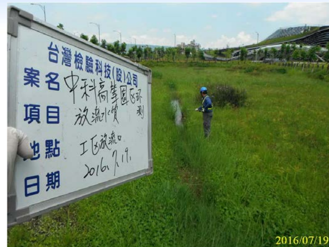
南核心區雨水調節池
