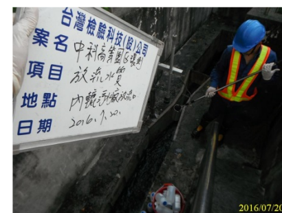
內轆污水廠放流口
