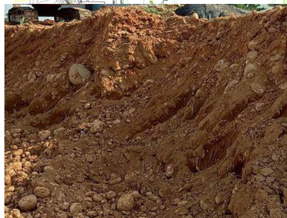
台積電15廠P7棟新建工程(106.09.29)
