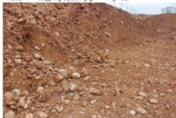
台積電15廠P7棟新建工程(106.08.24)
