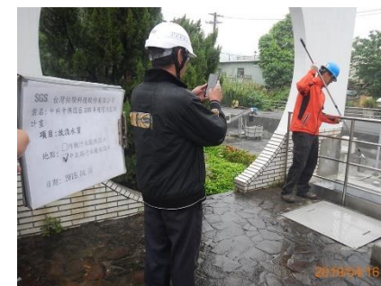
中正路污水廠
