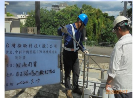
中正路污水廠
