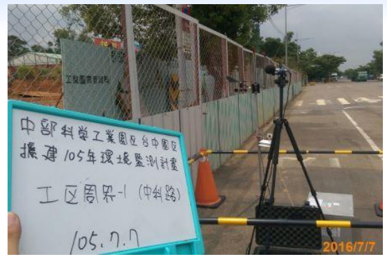
工區周界1(中科路)
