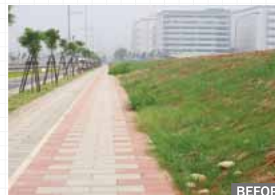
建設中的中科路人行道
