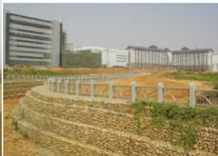
◎ 建設中 / 大社支線 / 二期先期水保
