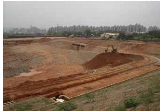
▲ 東大滯洪公園施工中
