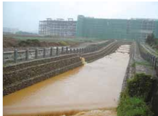
◉ 建設中 / 大雨中的大社支線
