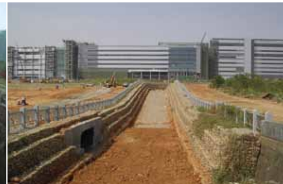
◉ 建設中 / 大社支線 / 二期先期水保
