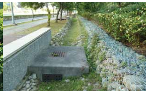
◉ 科雅路旁的排水溝
