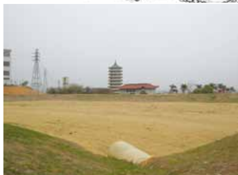
◎ 建設中 / 水堀頭滯洪池 / 二期先期水保
