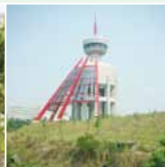
○ 南區高架水塔
