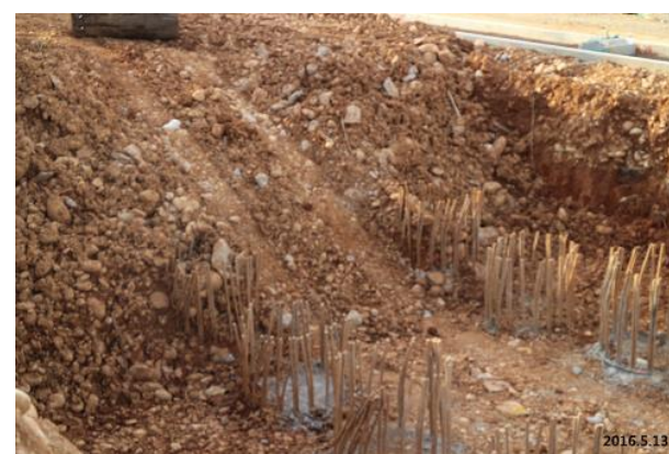
台積電中科F15P6CUP設備棟興建工程
