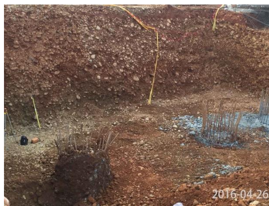
台積電中科F15P6興建工程
