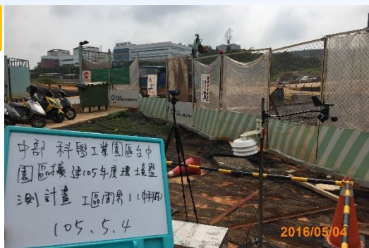
工區周界1(中科路)
