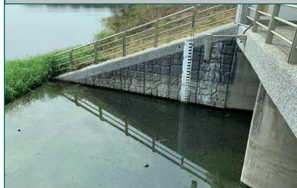
颱風來臨前：調節滯洪池水位至呆水位
