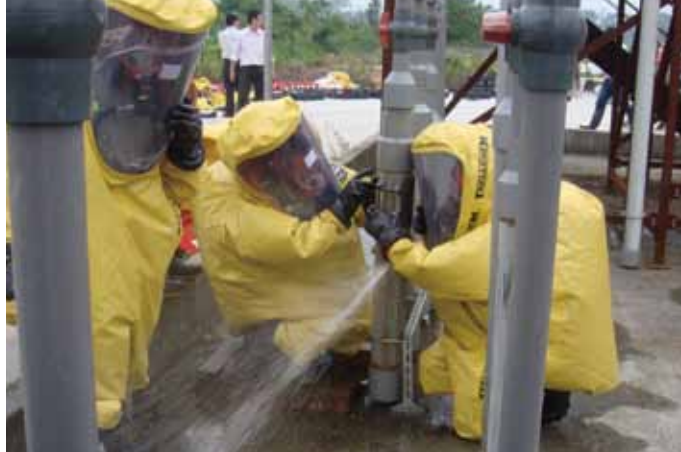
學員穿著A級防護衣，揹著空氣呼吸器，將外洩毒化物的鋼瓶置入ERC(緊急應變鋼瓶運送車)中止漏
