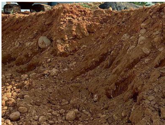
台積電15廠P7棟新建工程(106.09.29)
