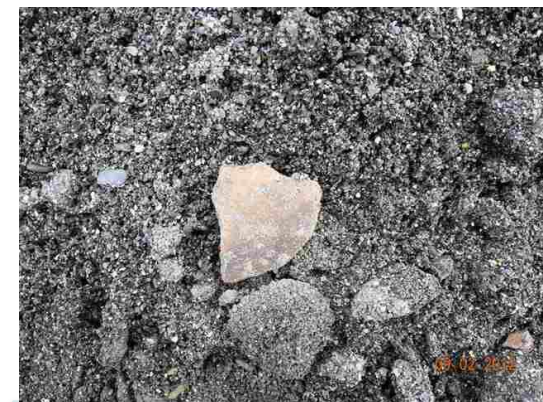
60公尺道路污水管路工程開挖
