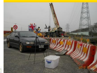
彰129縣道附近營建工程噪音振動監測
