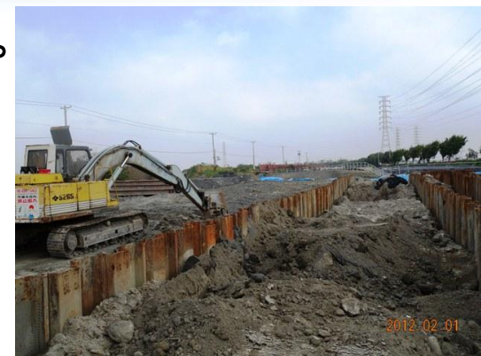
24公尺道路及管線工程開挖
