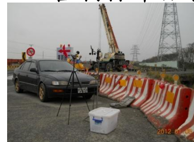
彰129縣道附近 營建工程噪音振動監測
