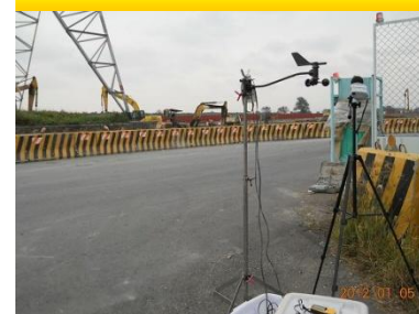
60米道路終段營建工程噪音振動監測
