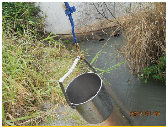
彰129萬芳橋旁沉砂池排放口
