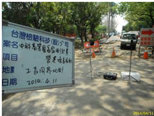
工區周界北方
