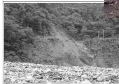
烏石坑林道2K+200下邊坡崩塌
