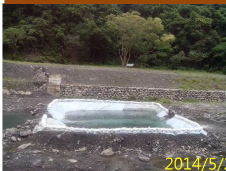
沉砂池控制濁度
