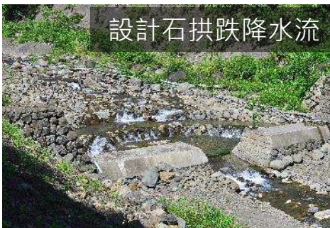
固床工開口營造低水流路
