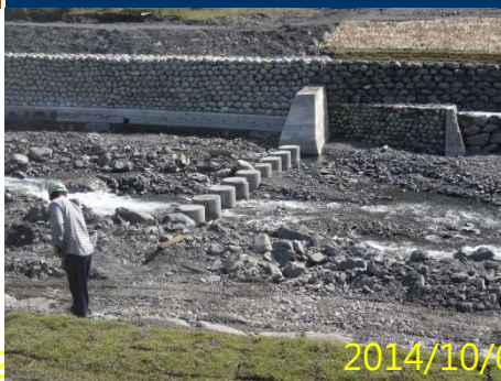
低落差固床工與砌石護岸
