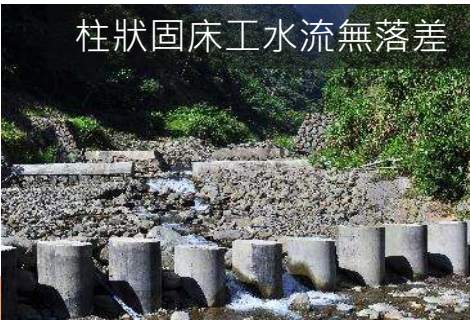
固床工開口營造低水流路
