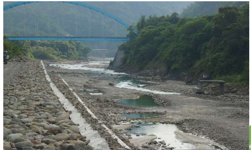
103年度曾文水庫集水區主流茶山大橋上游河道護岸工程
