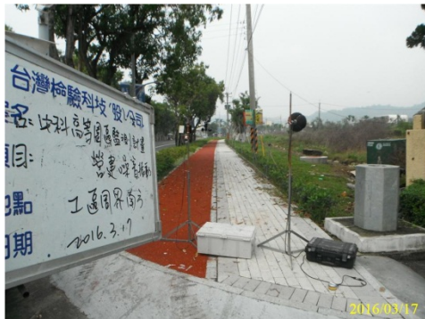
工區周界南方
