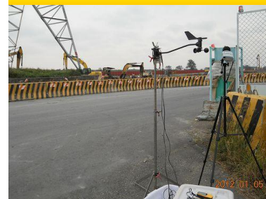
60米道路終段營建工程噪音振動監測
