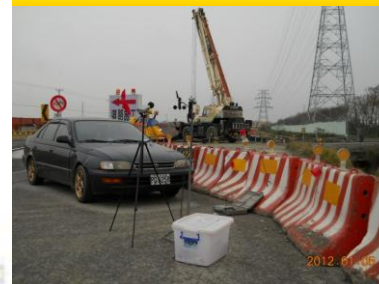
彰129縣道附近營建工程噪音振動監測
