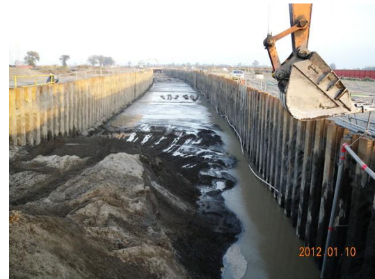
60公尺道路排水箱涵開挖
