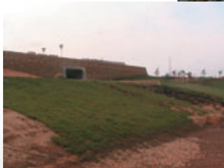
箱涵排入滯洪池
