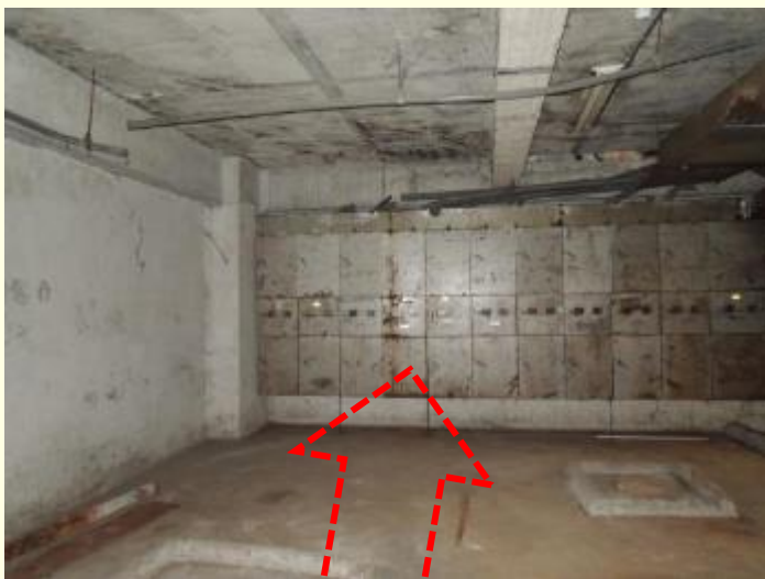
現況照片：汽車升降機到達 地下二樓停車場
