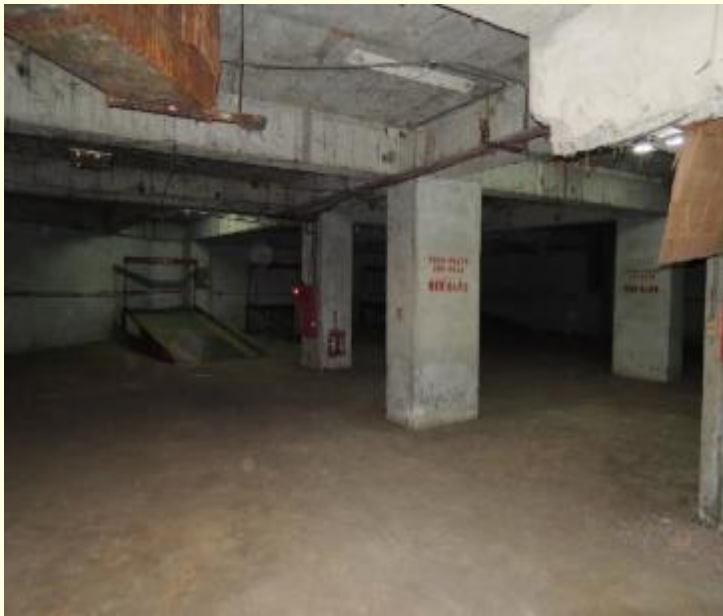
現況照片：車道
