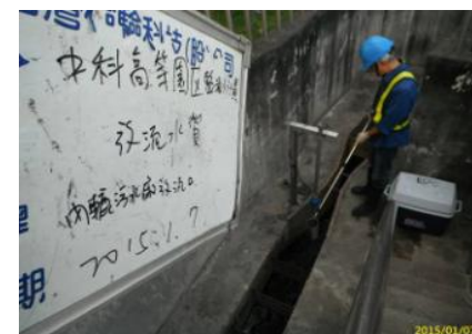
內轆污水廠放流口
