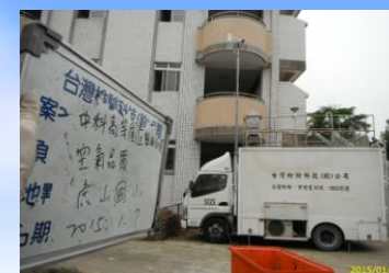
虎山國小環境現況
