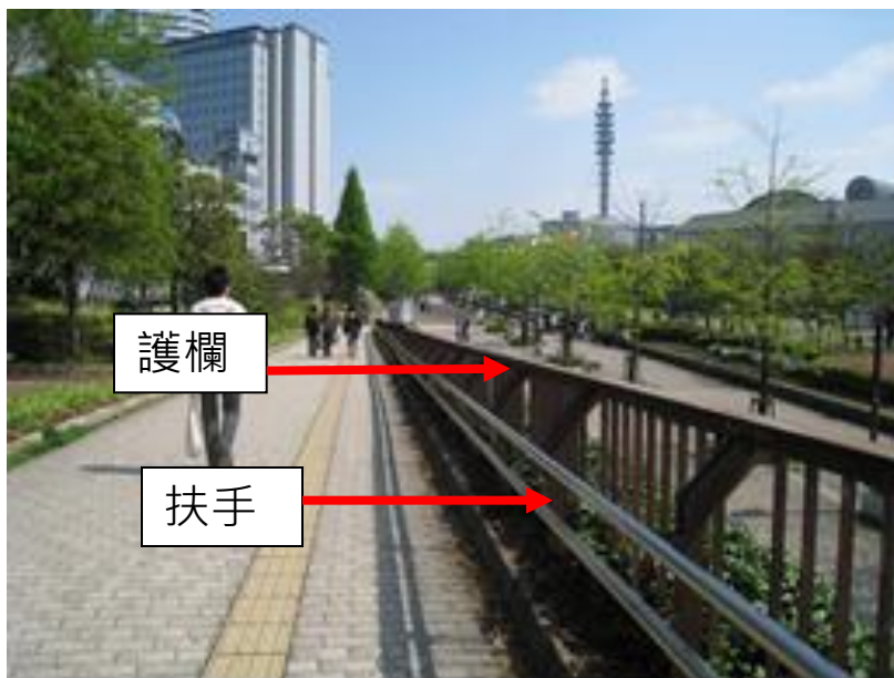
防護設施護欄與扶手
