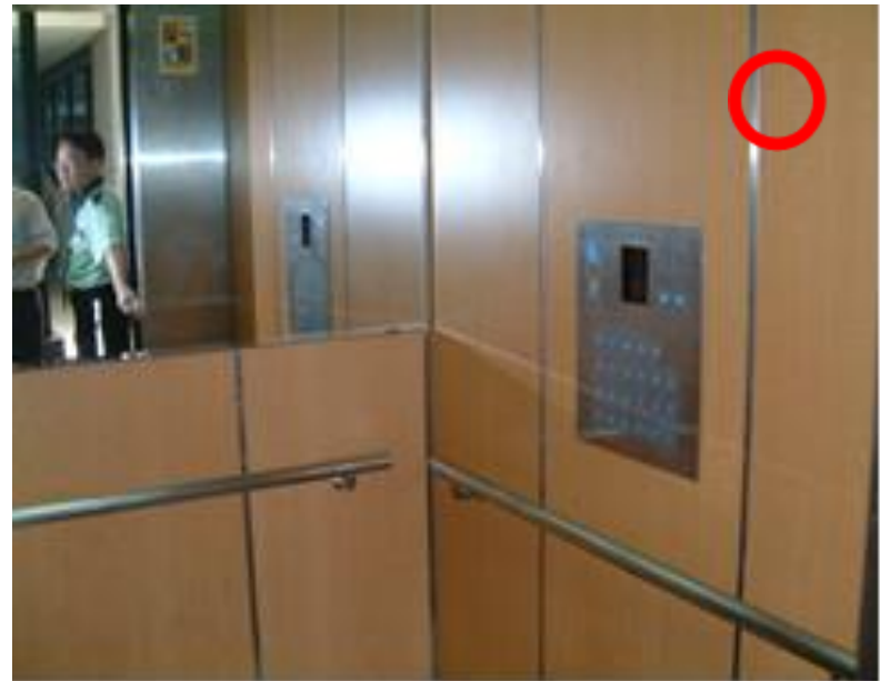
輪椅使用者操作盤設置參考案例
