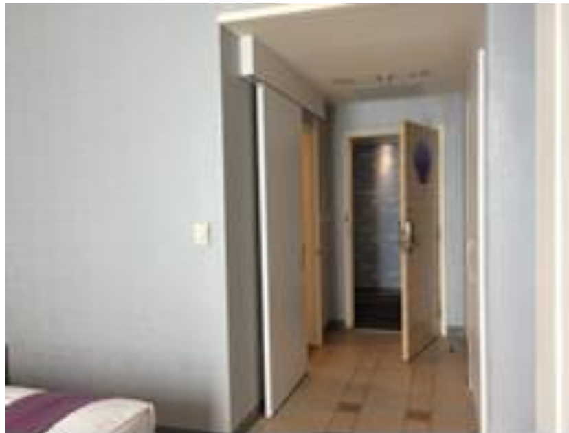
客房之地面應平順、防滑，出入口尺寸及操作空間要符合規範
