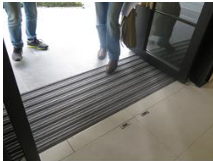
避難層出入口設置截水溝參考案例，右側照片刮泥墊下為截水格柵
