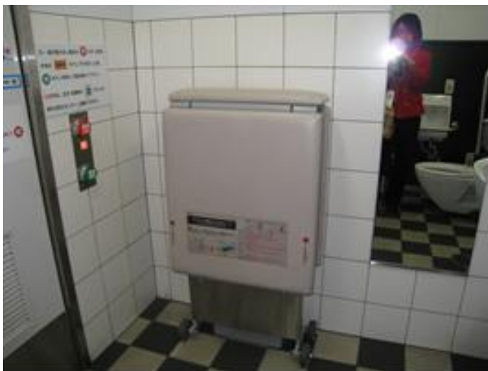
廁所設置照護床，供成人更換尿片
