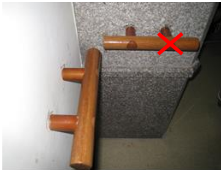
扶手應採L型方式支撐，以免影響扶著扶手前進之順暢性
