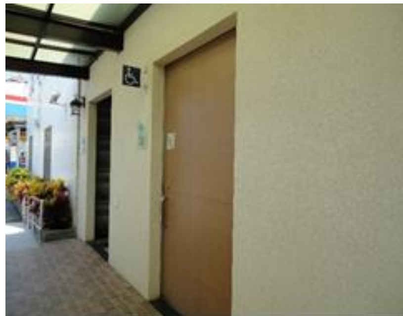
主要通路走廊與浴室開門方向平行應設置垂直牆面之無障礙標誌
