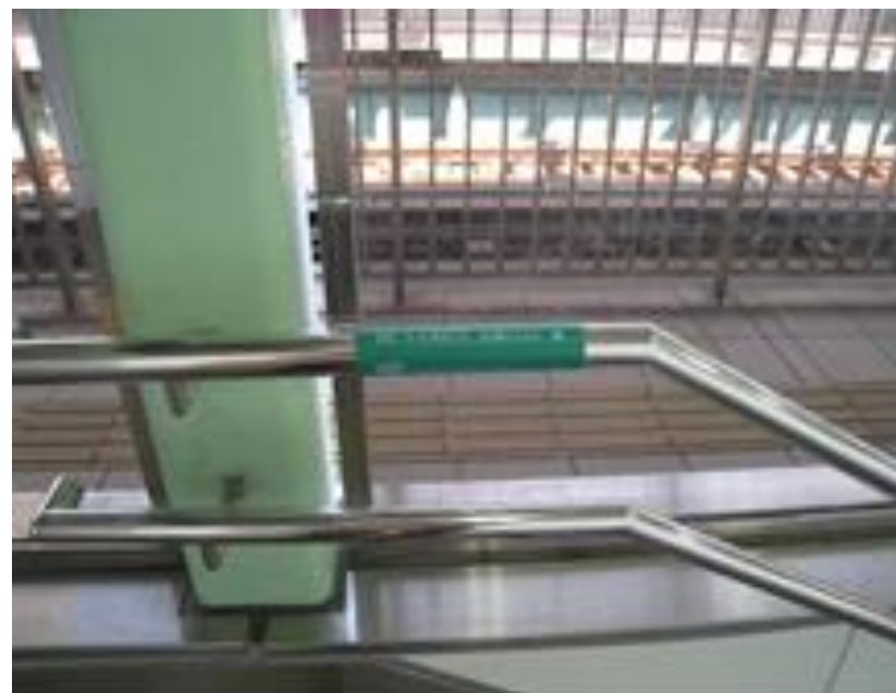
樓梯頂端扶手點字設在水平延伸處
