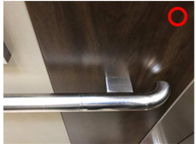
昇降機門為單側開啟式未設門框側扶手端部作防勾撞處理參考案例
