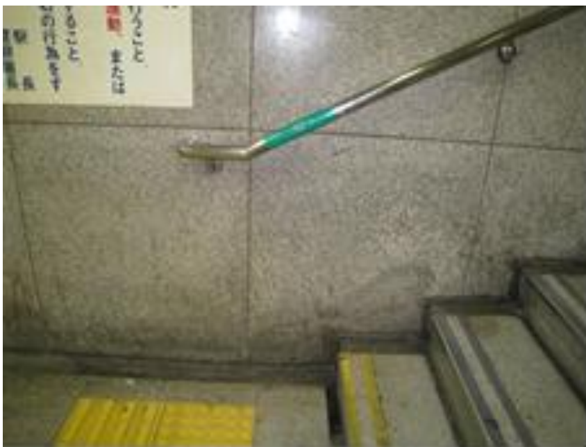
樓梯起始階扶手點字設在水平延伸後側
