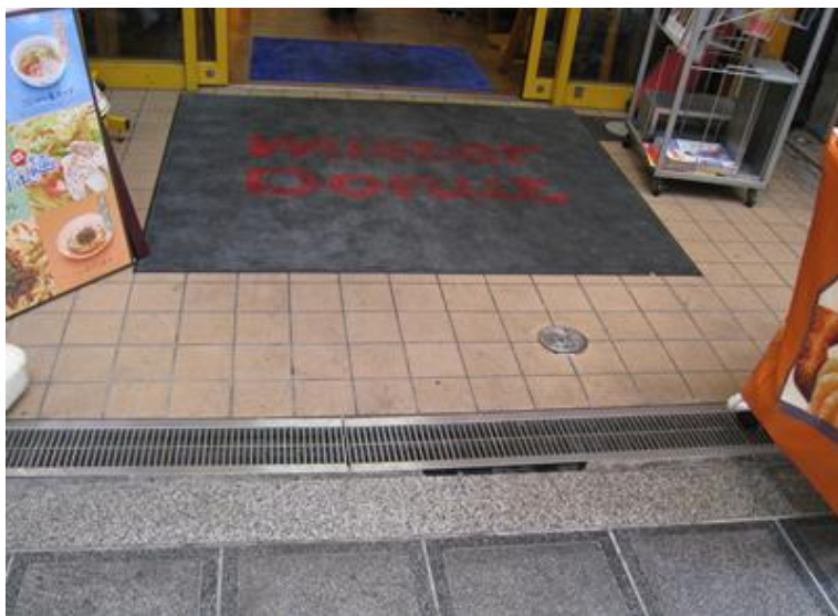
避難層出入口設置截水溝參考案例，右側照片刮泥墊下為截水格柵
