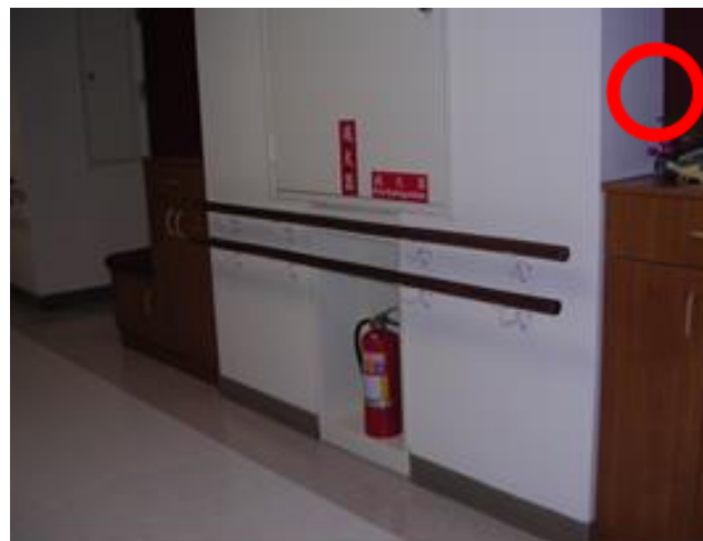
預先於牆壁設凹洞以放置滅火器
