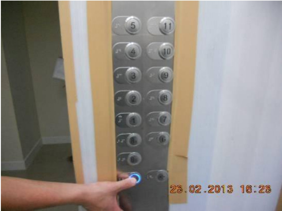
主操作盤設置點字案例
