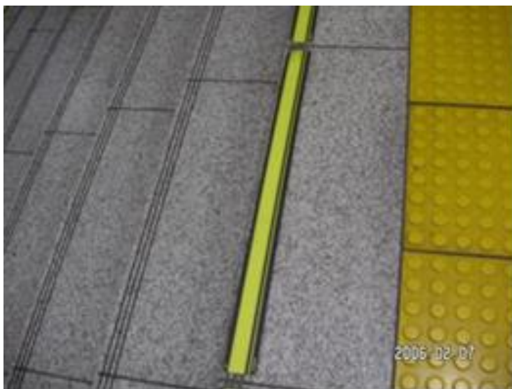
以警示磚設置警示設施案例
