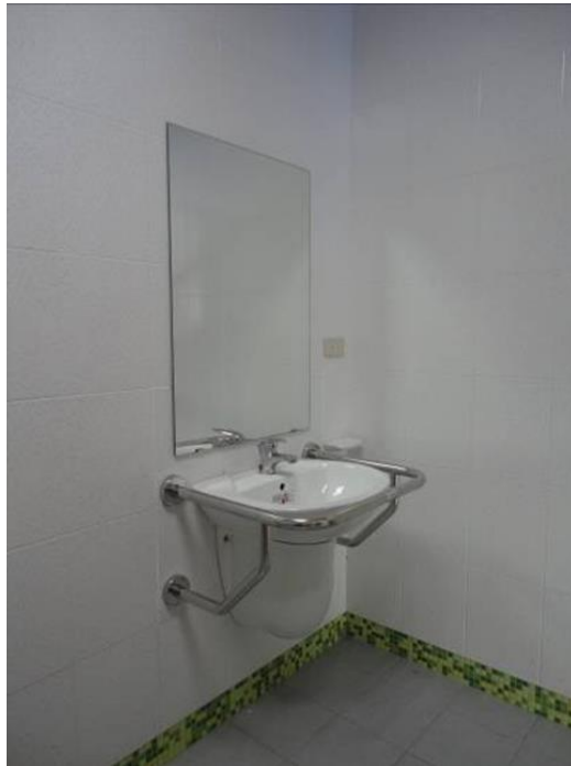
洗面盆上鏡面應平貼鏡面下緣高度90公分鏡面高90公分
