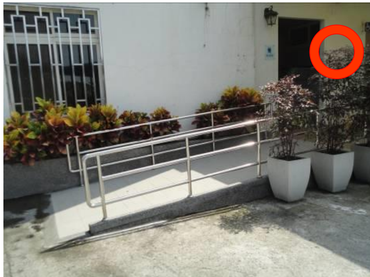
坡道扶手端部防勾撞處理
