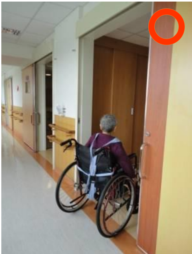
推拉門應留設輪椅 操作空間便利輪椅通行。
