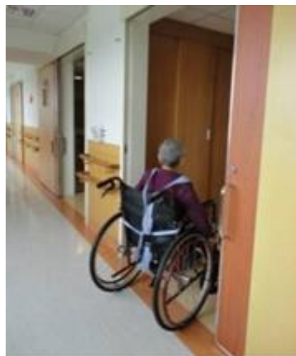
輪椅使用者在90公分寬通路走廊轉彎，轉彎處需120公分以上的空間
