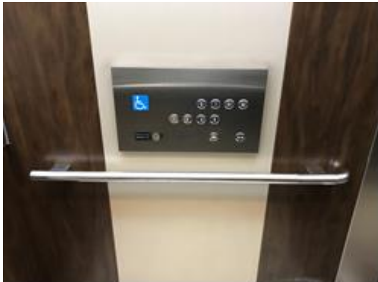
輪椅使用者操作盤設置參考案例
