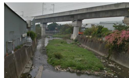
筏子溪上游生活污水排放現況
