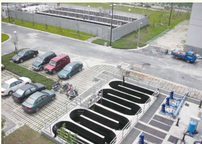
虎尾園區的污水處理設施
