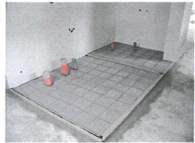
泥作進場 Cement Engineering
