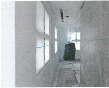
設備進場 Equipment installation
