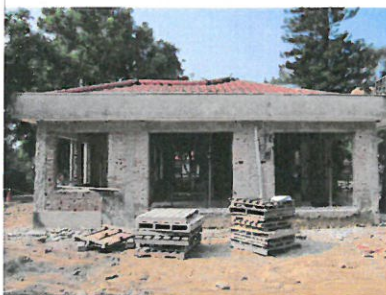
舊宅拆除整理 Old house demolition
