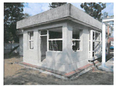
外牆整理 Facade Engineering
