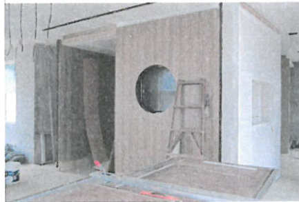
室內裝修進場 Interior decoration
