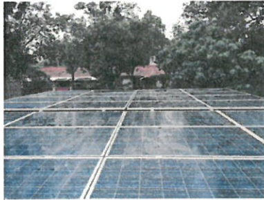
鋪設太陽能板 Solar panel layout
