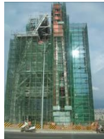
西區水塔正立面現況影像
