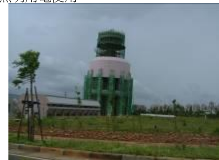
南區水塔立面現況影像
