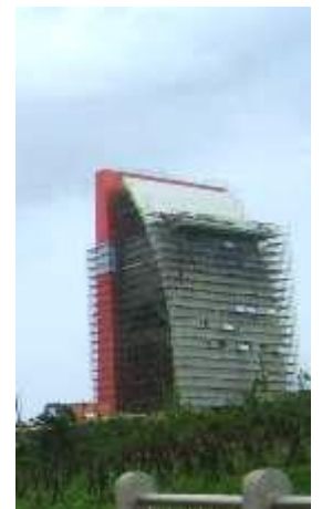
西區水塔側面現況影像
