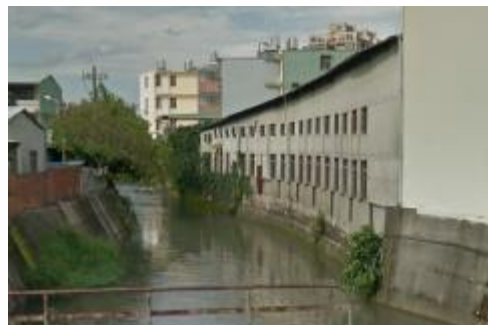
筏子溪上游生活污水排放現況
