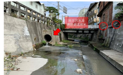
和平橋(旱溝排水)現場環境
