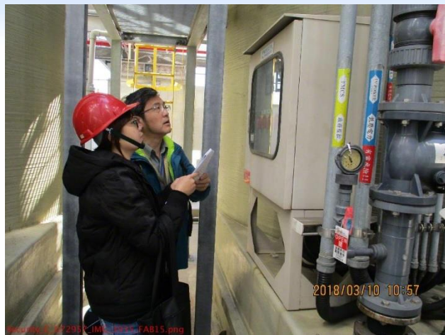
確認污染防制設備運作情形
