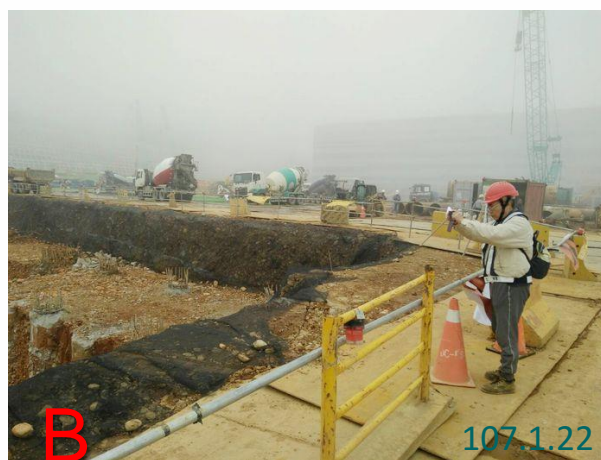
台積電中科FAB基礎開挖(107.1.22)
