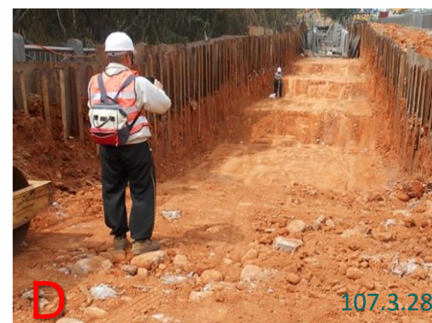
西區配合工程及景觀工程(107.3.28)
