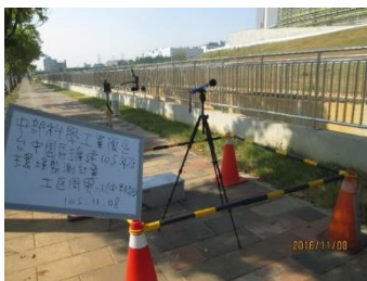
工區周界1(中科路)
