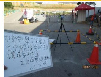
工區周界2(科園路)
