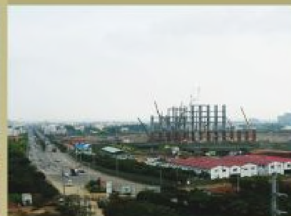
95.06.30本廠廠區與三豐路現況
