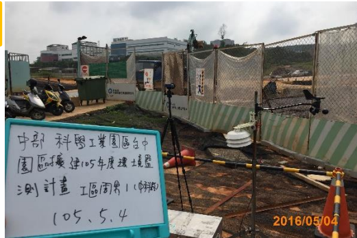
工區周界1(中科路)
