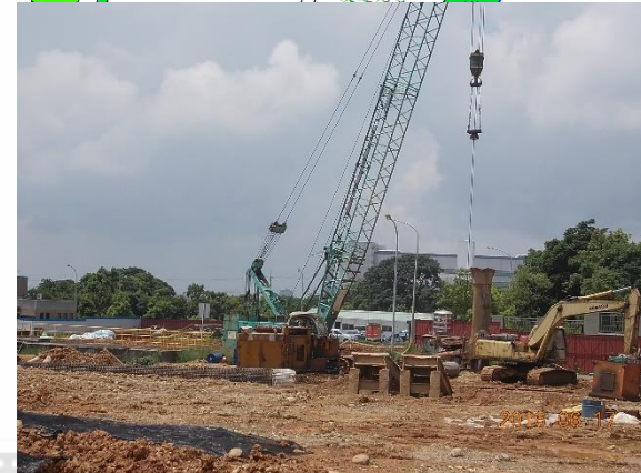
污水廠四期工程施工情形
