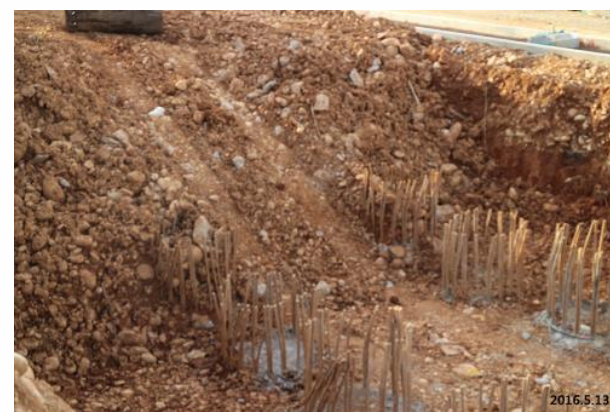
台積電中科F15P6CUP設備棟興建工程
