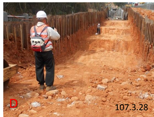
西區配合工程及景觀工程(107.3.28)
