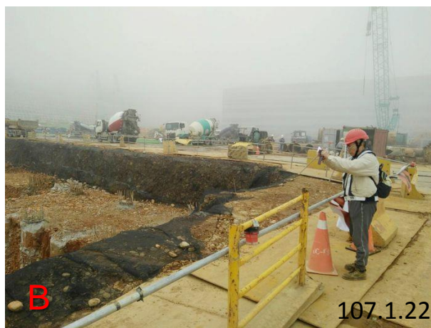
台積電中科FAB基礎開挖(107.1.22)
