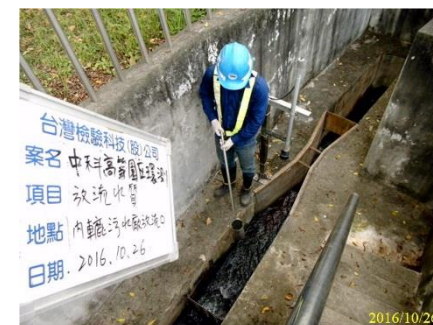
內轆污水廠放流口
