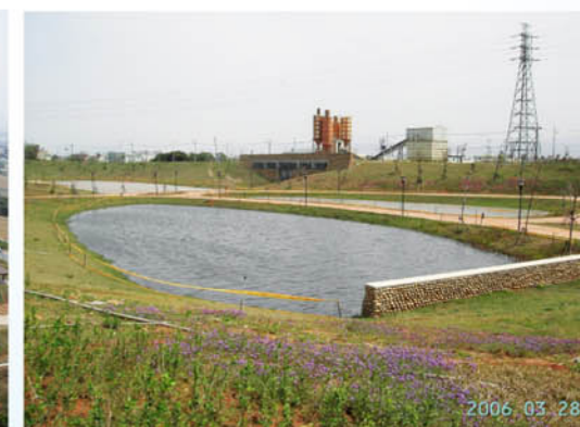
2006.03.28 雨後蓄滿水的滯洪沉砂池
