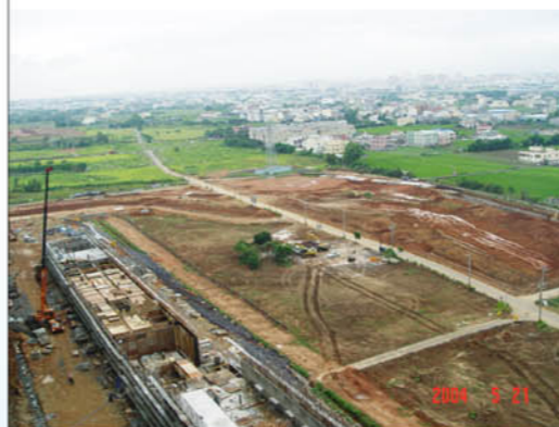
2004.05.21 開挖中的滯三滯洪池及建設中的友達一期廠
