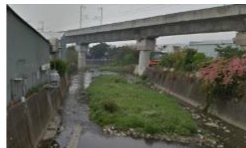
筏子溪上游生活污水排放現況
