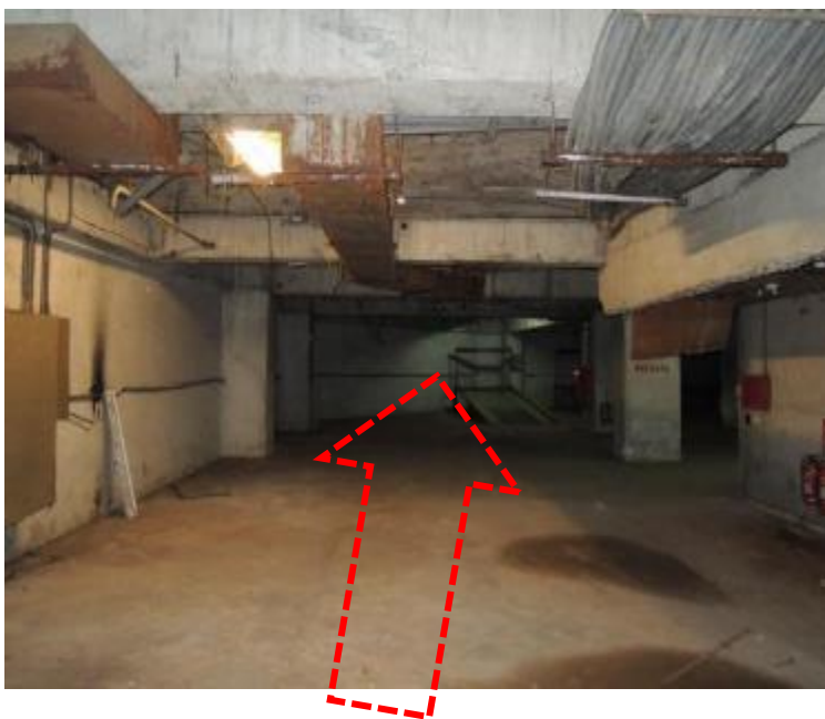
現況照片：車道
