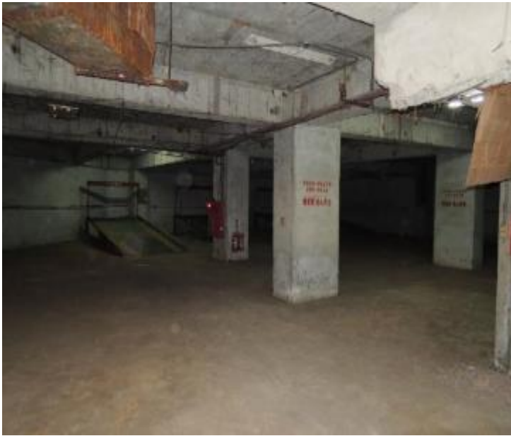
現況照片：車道
