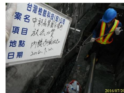
內轆污水廠放流口
