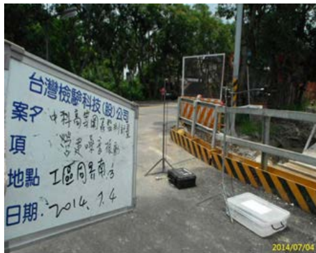
工區周界南方
