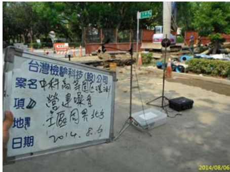
工區周界北方
