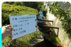
半路溝排水 內明橋
