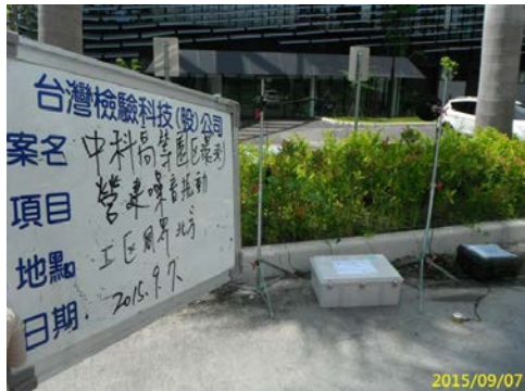
工區周界北方
