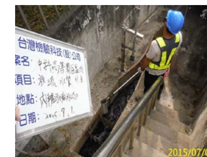
內轆污水廠放流口
