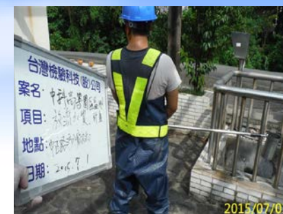
中正路污水廠放流口
