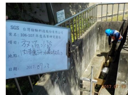
內轆污水廠放流口
